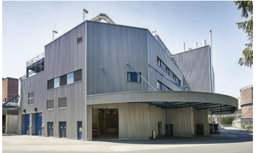
Neue zentrale Klärschlammverwertungsanlage im Klärwerk Werdhölzli. Gegenüber der dezentralen Verarbeitung ist dies effizienter und spart den Kommunen Kosten. Quelle: ERZ
