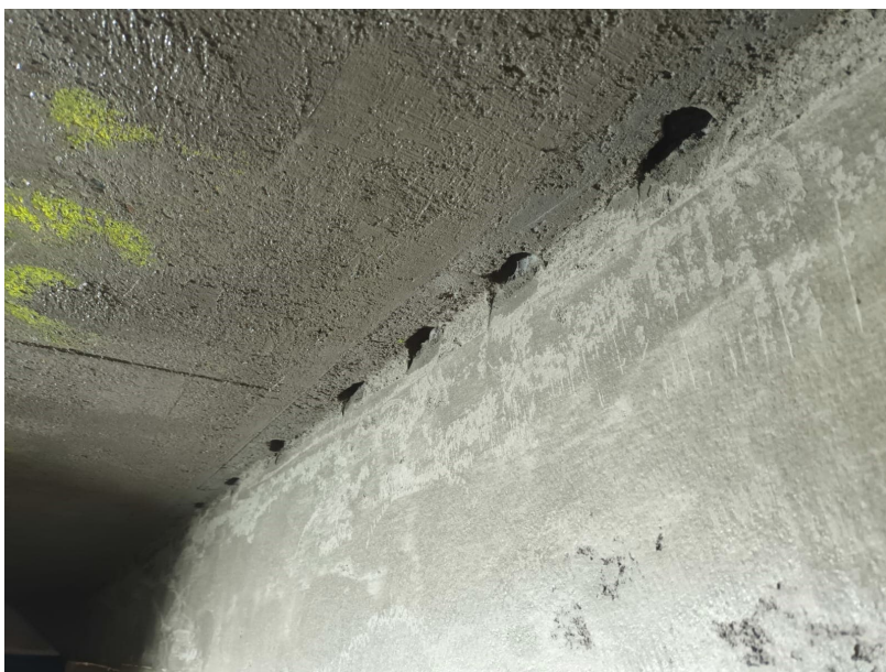
Abbildung 6: Bohrungen für Lamellen
