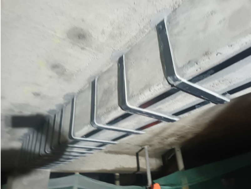
Abbildung 10: Montage Lamellen
