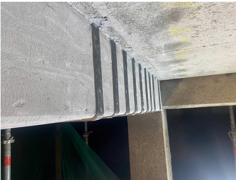
Abbildung 9: Montage Lamellen
