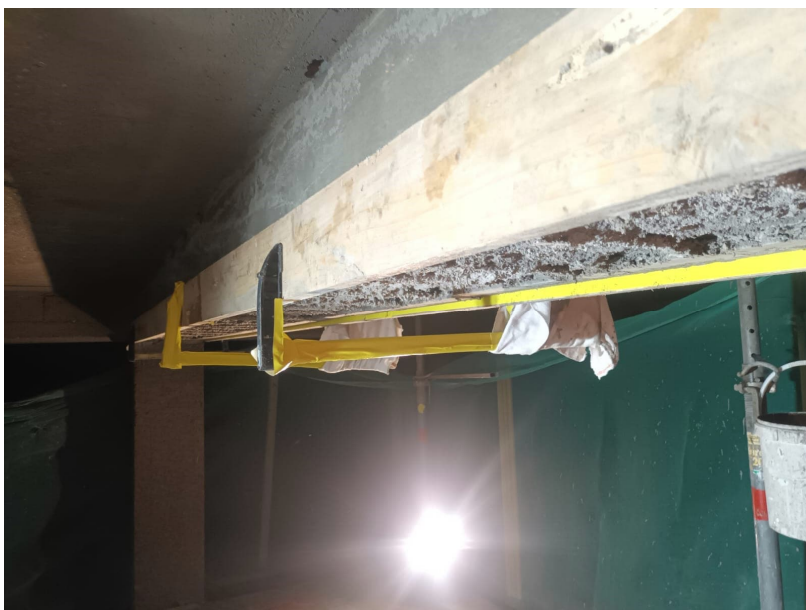
Abbildung 4: Reprofilierungsarbeiten
