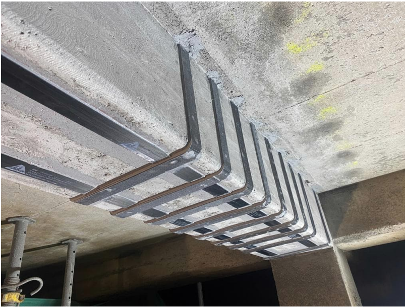
Abbildung 8: Montage Lamellen
