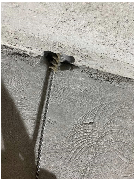
Abbildung 7: Bohrungen reinigen
